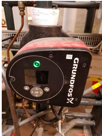
Figur 7. Cirkulationspump på VS-krets, frekvensstyrd.
