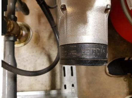
Figur 8. Cirkulationspump till VV.
